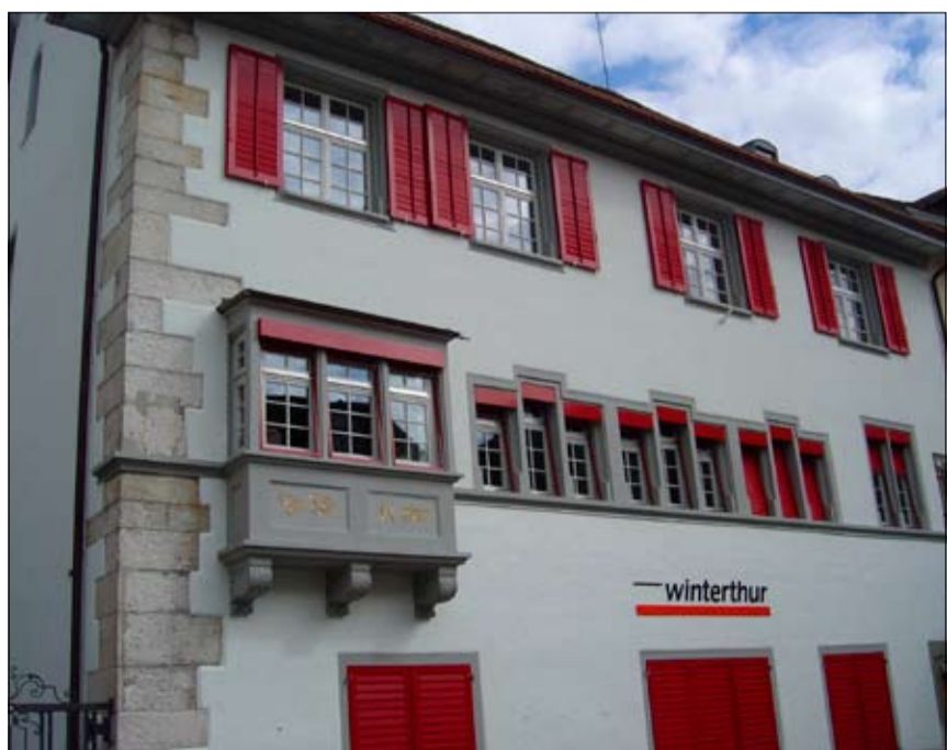
Die Fassade der Winterthur-Versicherungen in der Altstadt von Schaffhausen ist von Pfenninger Maler erneuert worden.
